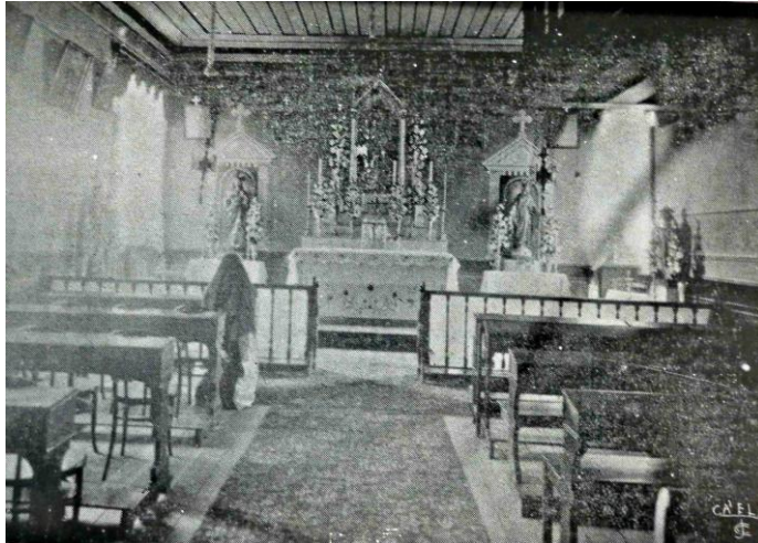
Fig. 62- Área interna em 1922. Fonte: Relatório da Santa Casa de Misericórdia, 1º de janeiro de 1923
