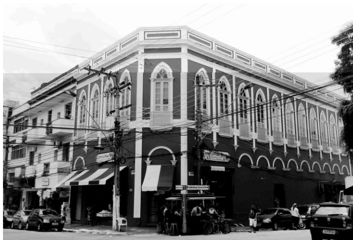
Fig. 70- Prédio na Rua Miranda Leão com Andradas. Foto acervo pessoal.
