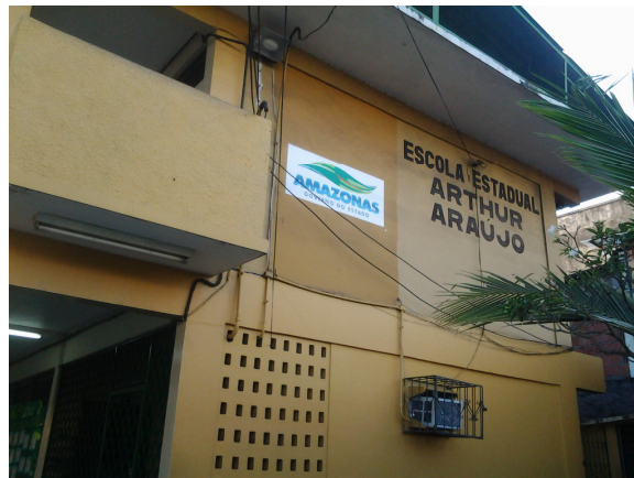
Figura 01 – Frente da Escola Estadual “Arthur Araújo”
