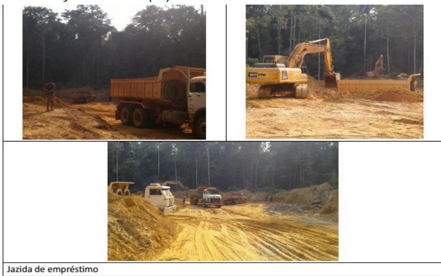
Jazida de empréstimo
