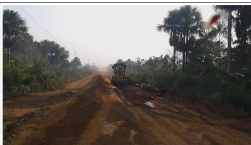
Execução da pista com largura variando de 12 a 18,6m.
