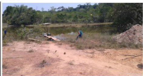
Captação de água do lago
