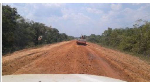
Serviços em execução com largura da pista atingindo 18,6m.
