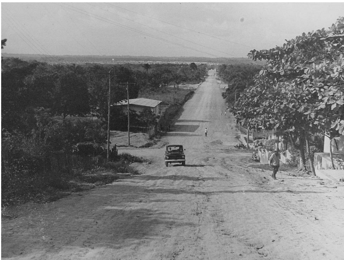
Figura Expansão da rua Paraíba, em direção ao conjunto do Parque Dez, em 1970, na foto declive próximo a rua Belo Horizonte
