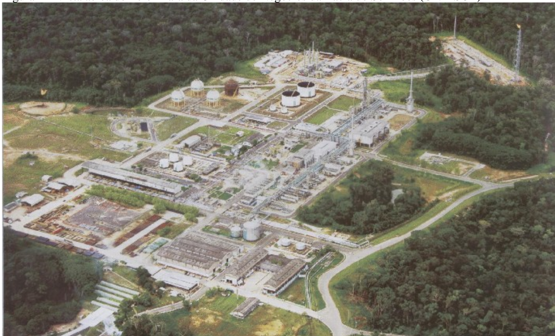
Figura 4 – Vista aérea do Pólo Arara da Unidade de Negócios da Bacia do Solimões (UN-BSOL)
