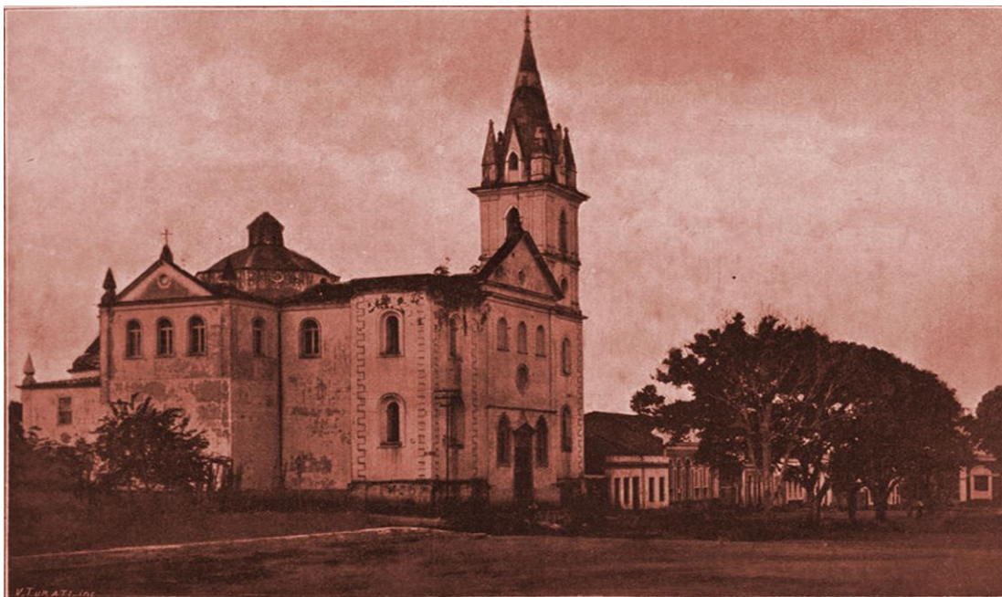
Fig. 2 – Igreja de São Sebastião
