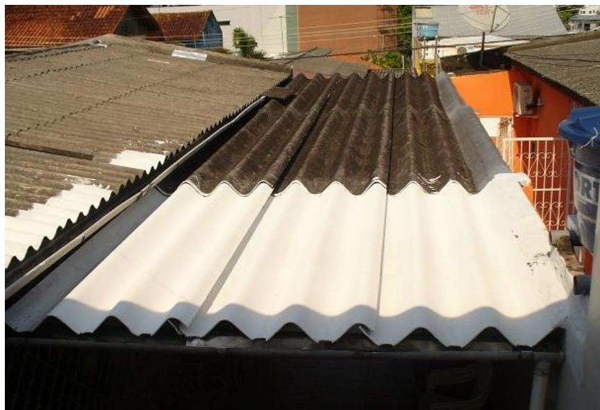
Figura 35 - Telha de fibrocimento com 7 mm de espessura.
