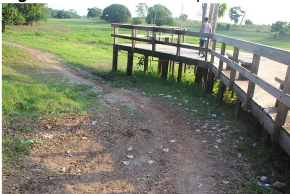
Figura 08. Vista lateral do píer.
