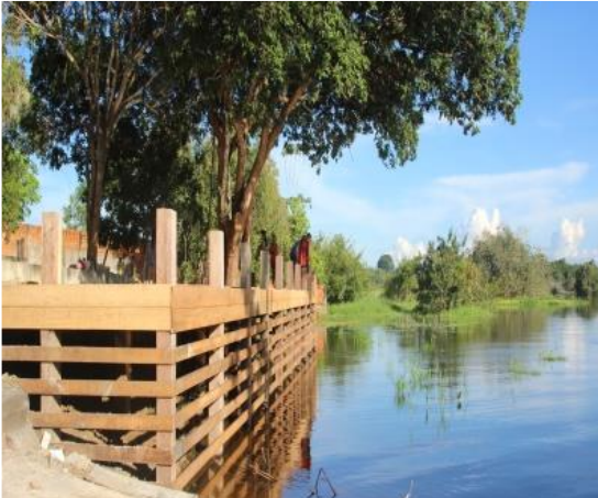
Figura 18. Reforma do Píer do Cantagalo.
