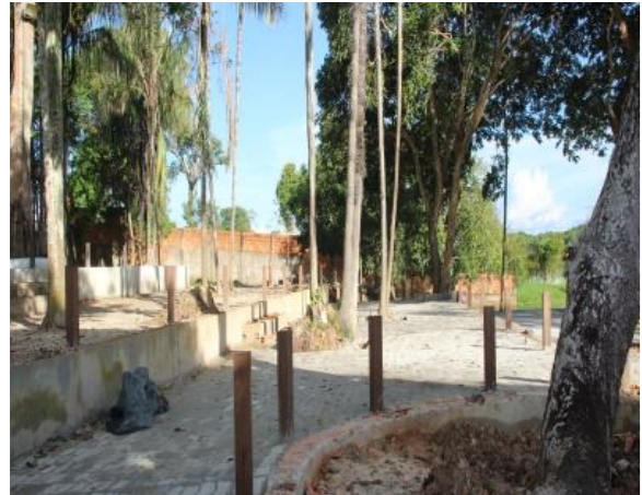
Figura 19. Calçamento da estrutura da área.
