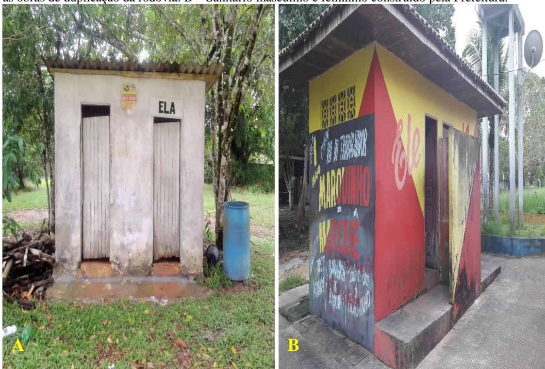
Figura 4-5: Banheiros do balneário do Miriti. A – Sanitário do restaurante flutuante Yara, removido devido as obras de duplicação da rodovia. B – Sanitário masculino e feminino construído pela Prefeitura.
