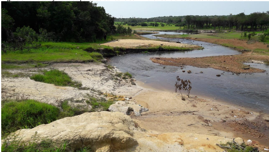
Figura 3-4: Leito a jusante da ponte do balneário do Miriti evidenciando o assoreamento do canal.
