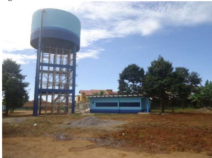
Figura 5: Reservatório elevado de 250 m 3
