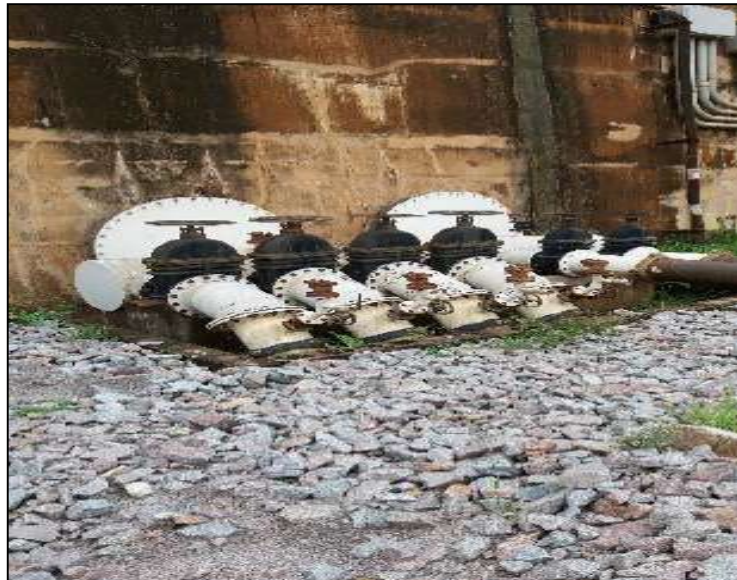
Figura 14: Captação 2, visão aproximada
