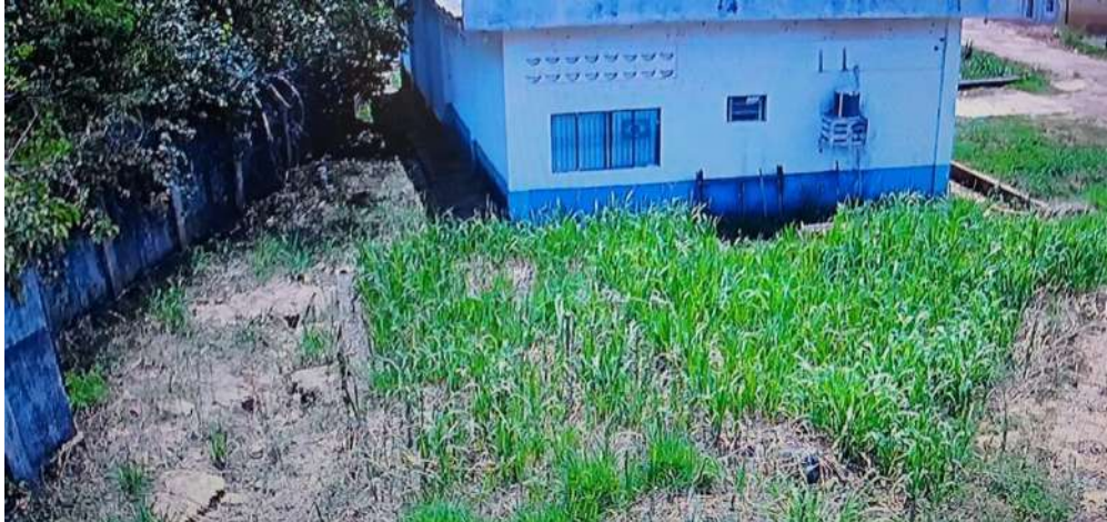
Figura 21: Estação elevatória de água bruta do Bate-Estaca
