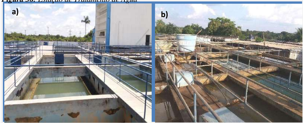
Figura 36: Estação de Tratamento de Água
