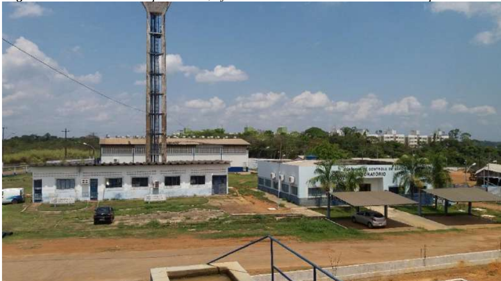
Figura 22: Laboratório de pitometria, oficina de hidrômetro e laboratório de qualidade
