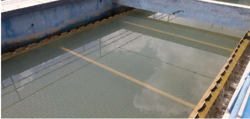
Figura 27: Decantador
