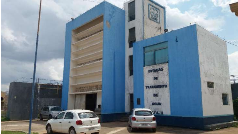
Figura 23: Fachada principal do prédio da ETA
