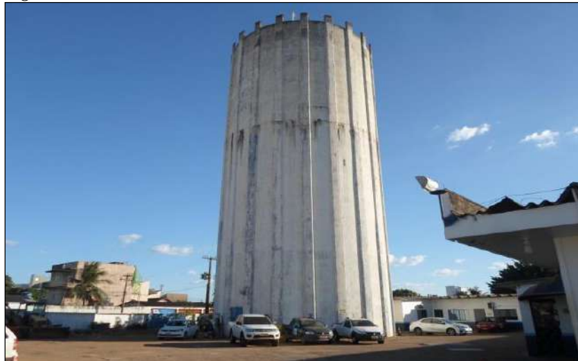
Figura 17: Reservatório elevado do CR1.
