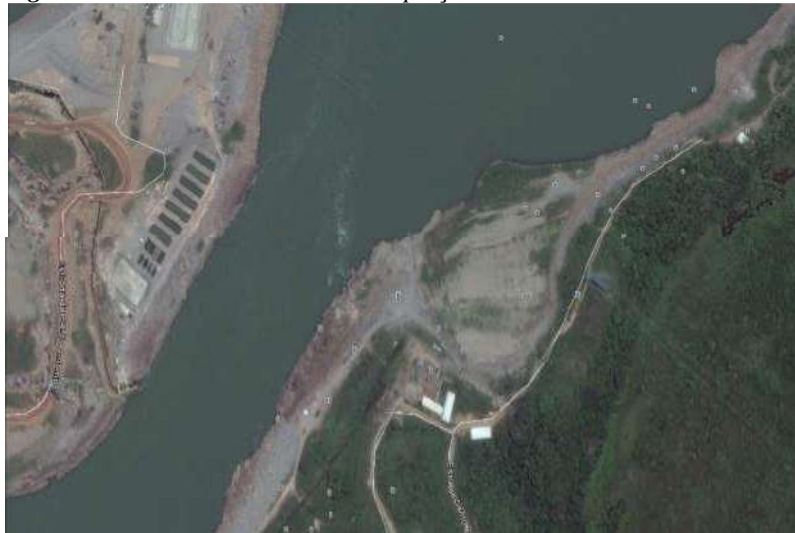
Figura 35: Vista aérea da área de captação do Rio Madeira
