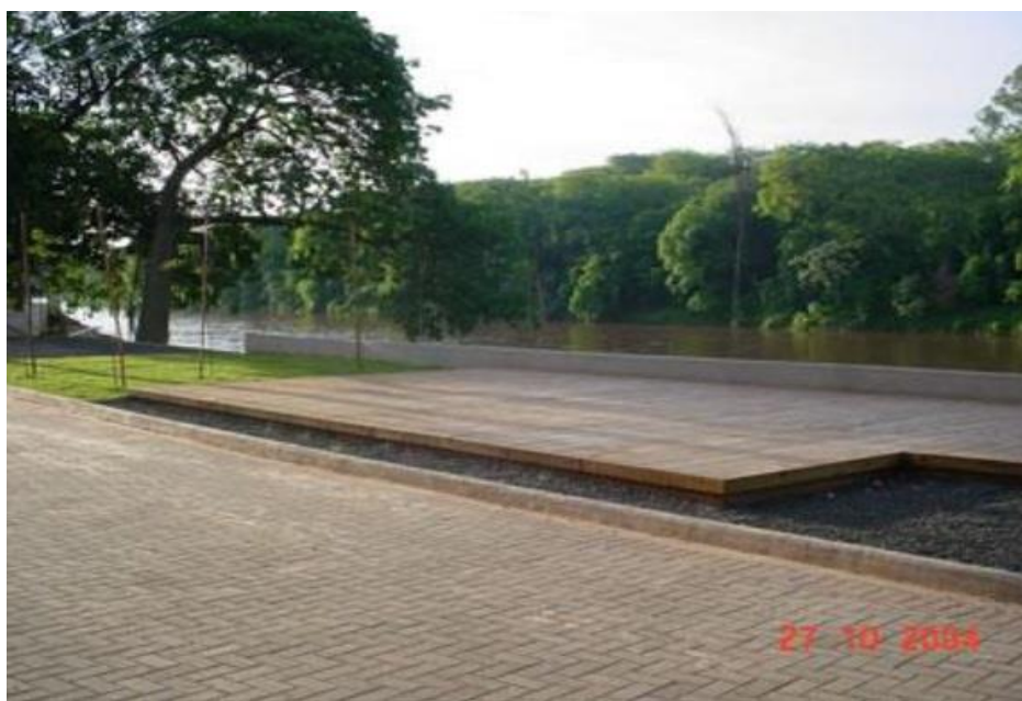
Figura 27: Rua do Porto - Intervenções
