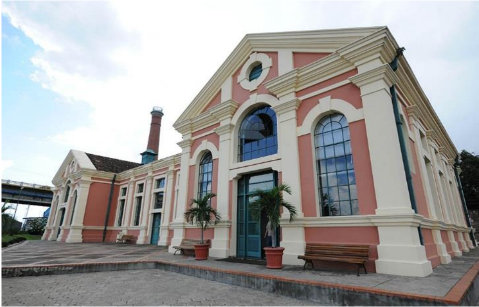
Figura 39 – Teatro Chaminé – Antiga Estação de Tratamento de Esgoto
