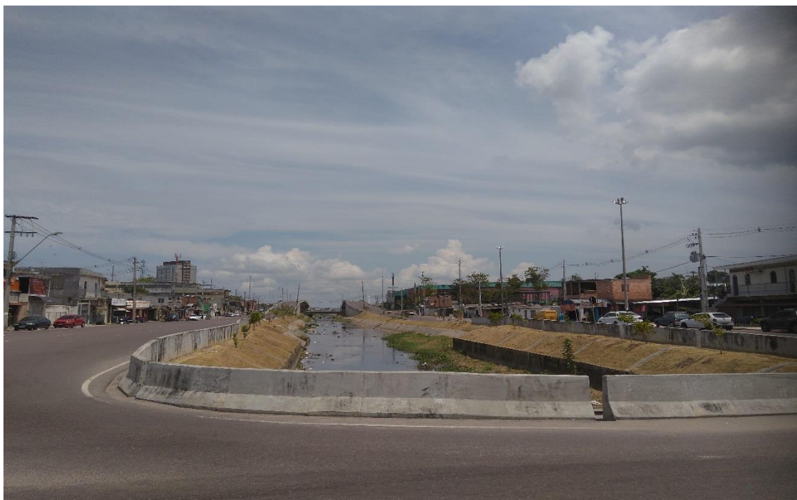
Figura 83: Canalização do Quarenta e viaduto ao fundo – Obras do PROSAMIM II
