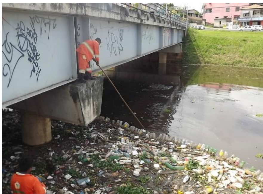
Figura 50 – Limpeza Igarapé na Avenida Brasil
