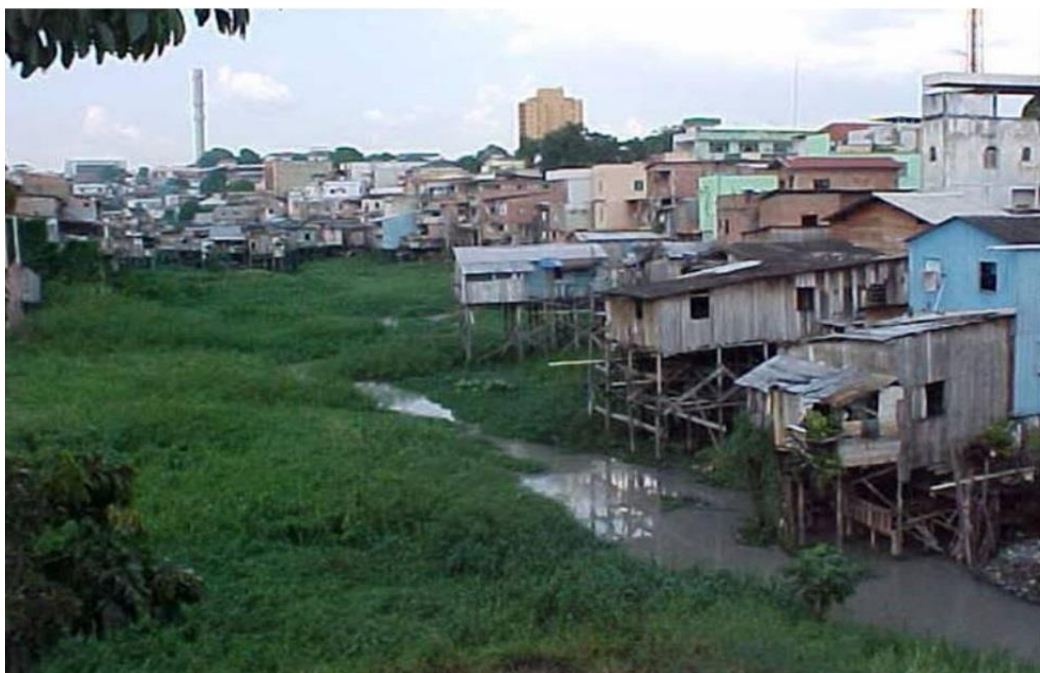
Figura 54: Igarapé de Manaus – Palafitas no leito do igarapé
