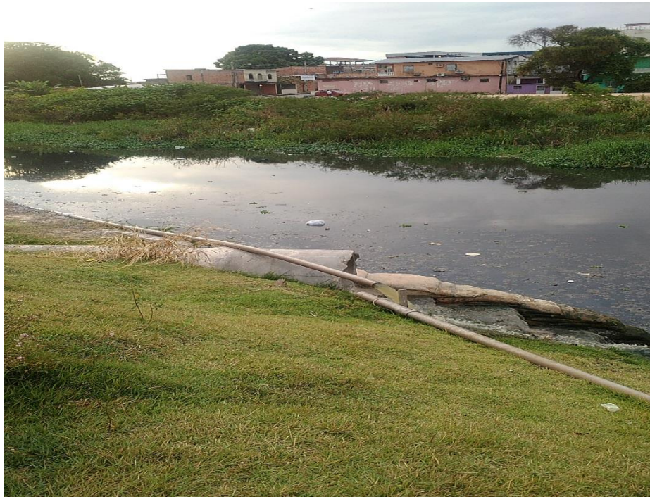
Figura 90: Lançamento de esgoto por tubulação
