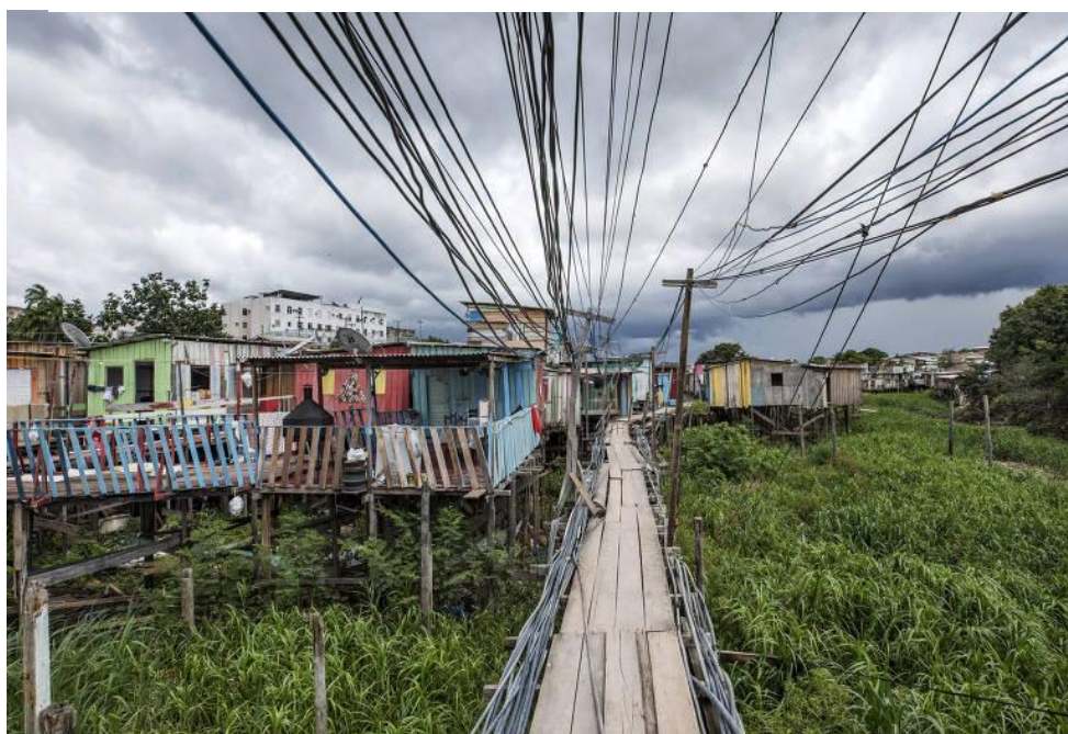
Figura 49 – Ponte de madeira no bairro Raiz, atualidade
