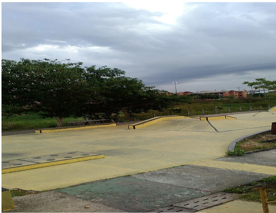
Figura 88: Infraestrutura de lazer, pista de skate, margens do Quarenta
