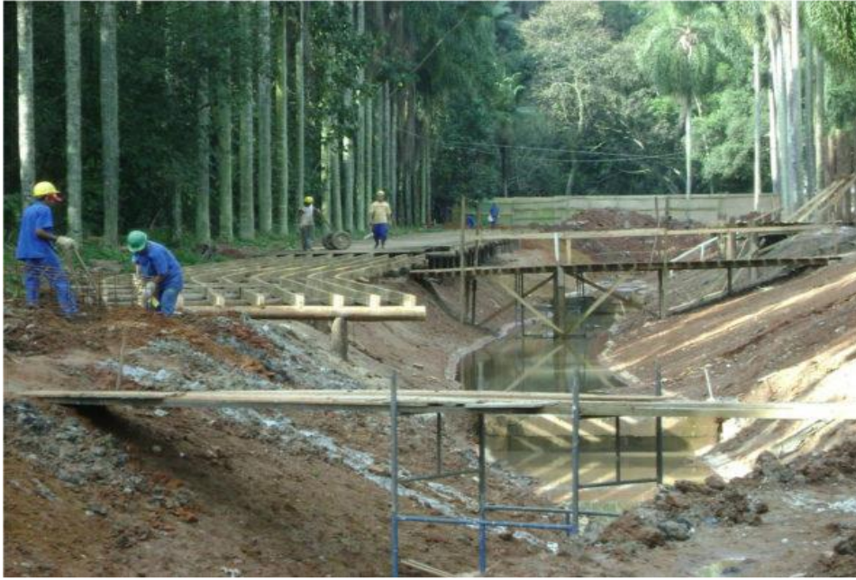
Figura 32: Construção de deck
