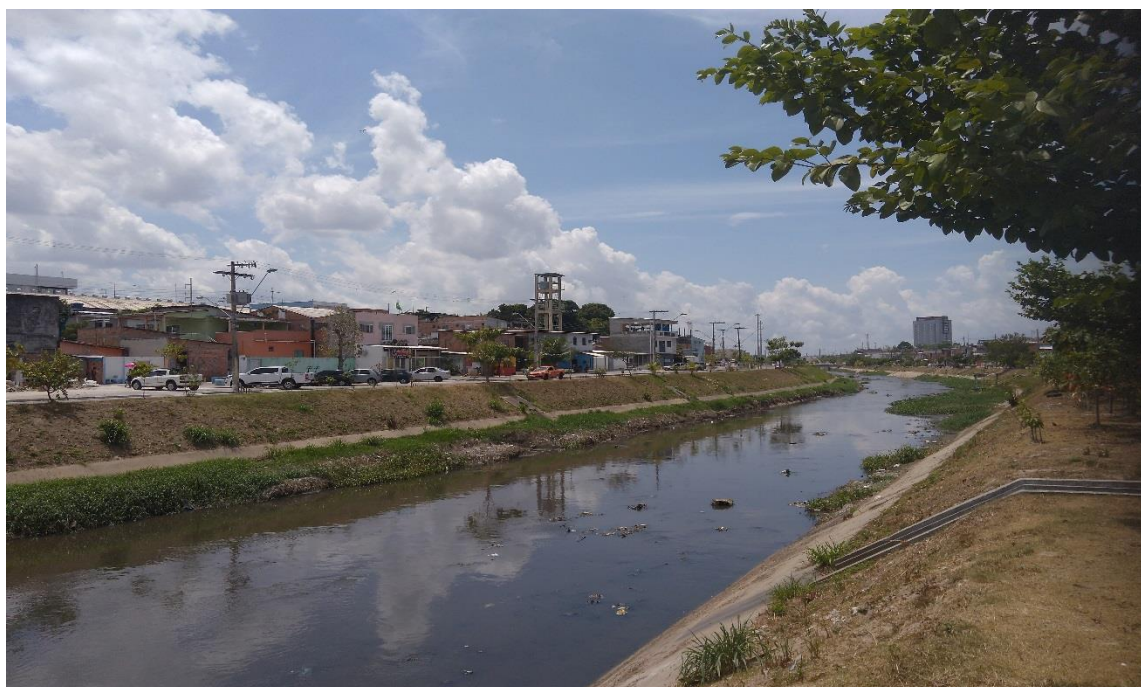
Figura 84: Canalização do Quarenta e ocupações residenciais de alvenaria
