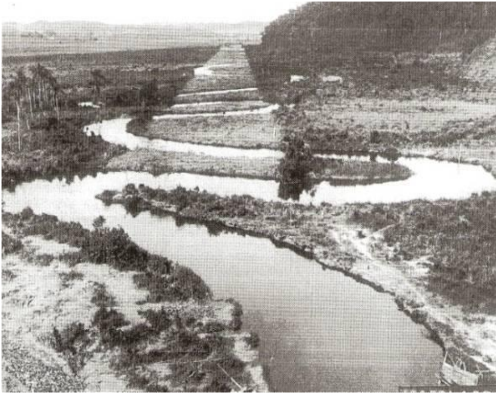
Figura 1 – Rio Pinheiros, SP, em processo de retificação por volta de 1929
