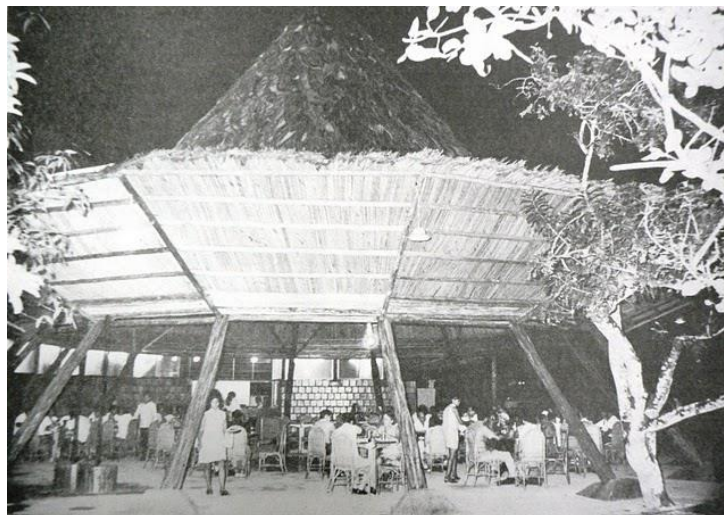
Figura 5 Restaurante Chapéu de Palha
