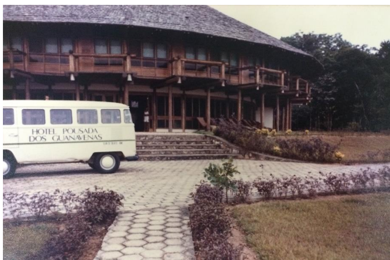
Figura 46 Prédio principal, em 1985
