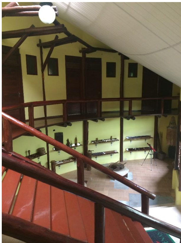
Figura 53 Forro adicionado no prédio
