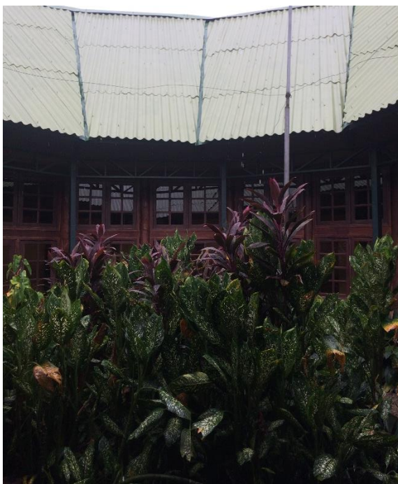
Figura 52 Atualmente em telhas metálicas
