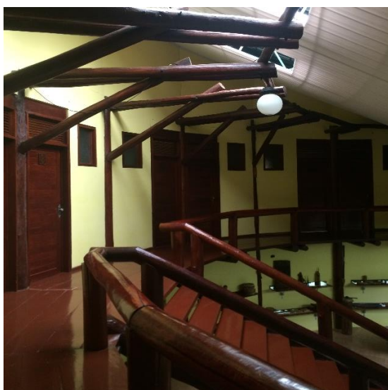
Figura 40 Apartamentos no pavimento superior
