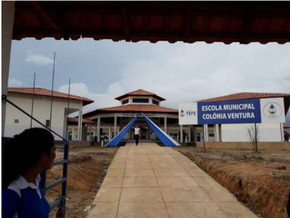
Figura 05: Novo Prédio da Escola Municipal Colônia Ventura, inaugurada em 2018.
