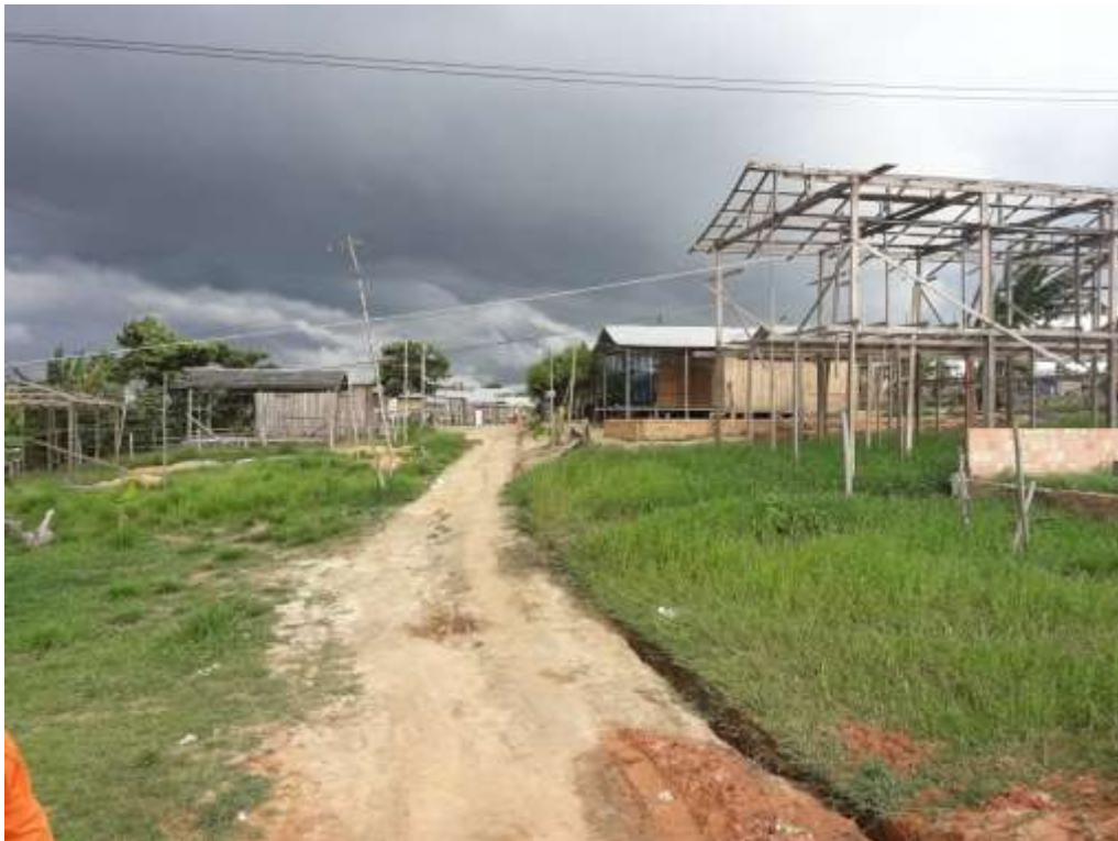
Figura 04: Situação da Rua I, Bairro Colônia Ventura, em Tefé-AM, sem pavimentação.
