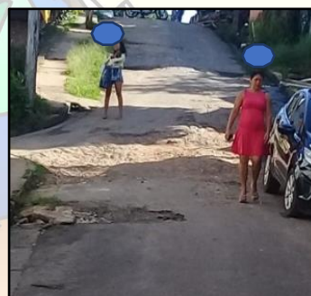
Foto 5- Rua: São Barnabé.
