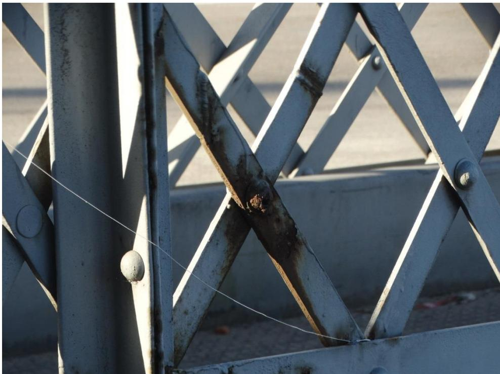
Figura 9. Presença de oxidação em uma das treliças que são responsáveis pela ligação da estrutura de ferro. Pode-se notar também, a presença de linhas de ‘papagaio’ e lixo. Fonte: NUNES, K. Junho, 2017.
