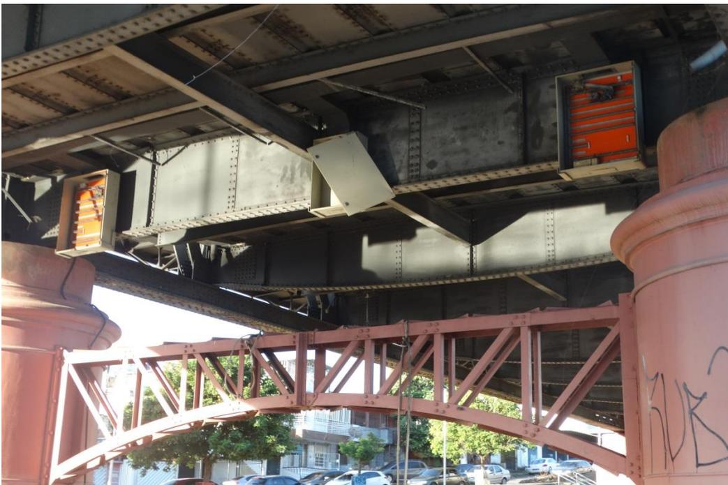
Figura 7. Caixas dos antigos fusíveis que controlavam a iluminação (não mais existente) violadas e danificadas. Restaram apenas às caixas, os fusíveis foram furtados. Localizadas na parte inferior da ponte. Fonte: NUNES, K. Junho, 2017.
