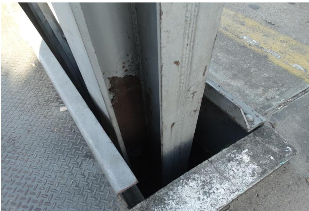
Figura 10. Desgaste gradual da pintura não original ‘cinza’ realizada na última revitalização de 2008, mostrando a ferrugem presente na pilastra de ferro da frente da Ponte. Fonte: NUNES, K. Junho, 2017.
