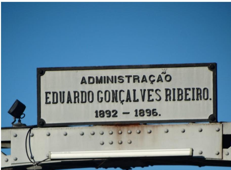
Figura 5. Placa localizada no topo da Ponte Benjamin Constant do referido governo de Eduardo Ribeiro, como sinalizador da finalização da obra em 1896. É possível observar oxidação e fiações de antigas luminárias. Fonte: NUNES, K. Junho, 2017.
