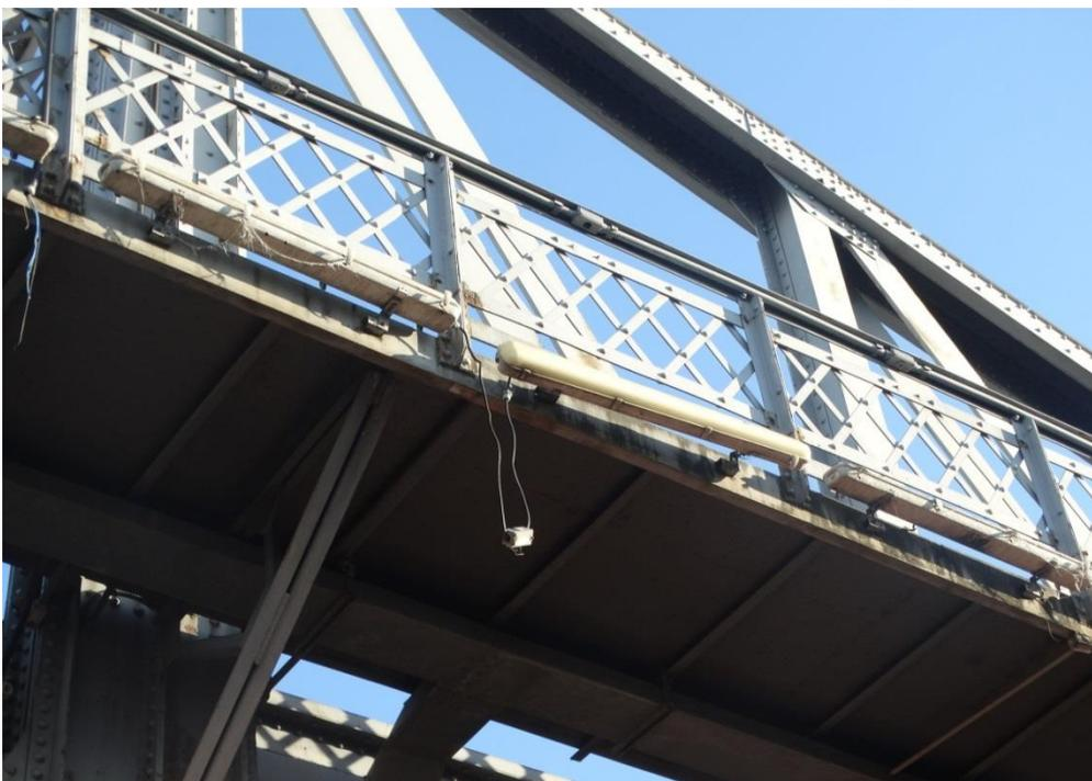
Figura 8. Interruptores das lâmpadas incandescentes e fiações destruídas. Localizada no lado externo da passagem de pedestre na ponte. Fonte: NUNES, K. Junho, 2017.
