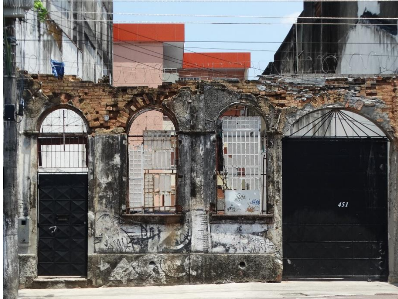
Figura 3 - Antiga instalação da Escola Infantil Bambi. Fonte: William Rodrigues, 2017.
